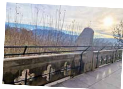
Terrasse du 2 e étage
