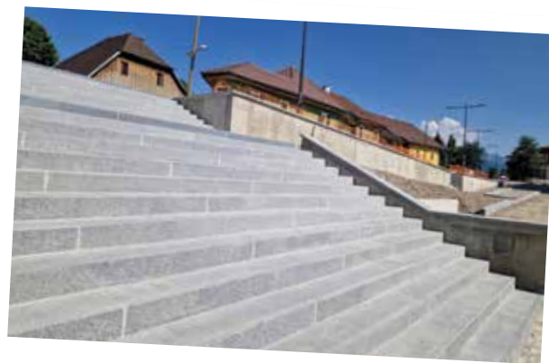
Escalier d'accès aux commerces
