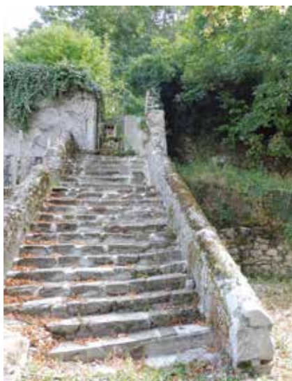
Escalier construit par les Rédemptoristes à l'extrémité nord-est de la propriété avec à droite un bassin vraisemblablement pour l'élevage de truites. L'eau amenée depuis Lossiège alimentait différents bassins et le couvent.
