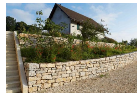
Murs de soutènement en paliers
