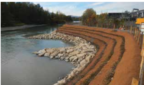
Restauration de la berge à La Grivaz, avril 2019. © SM3A
