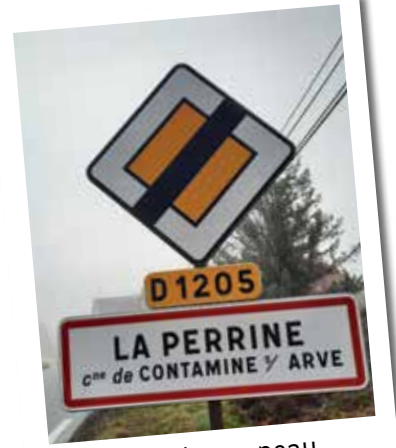
Pose de panneau d'agglomération La Perrine
