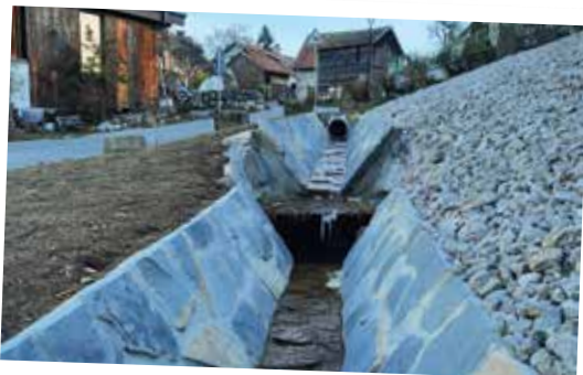
Aménagement au Ruisseau de Perraz
