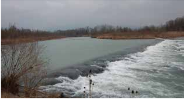
Le seuil de relèvement N° 2 au niveau de La Perrine. © SM3A
