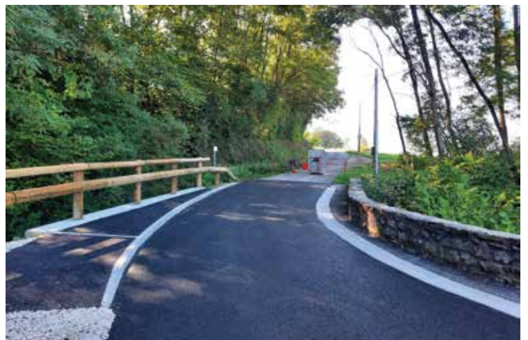
Réfection du pont de Clermont
