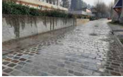
Pose de pavés
