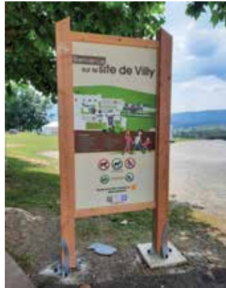
Pose d'un totem sur le site de Villy
