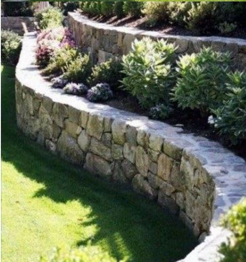
Murs de soutènement accompagnant la pente
