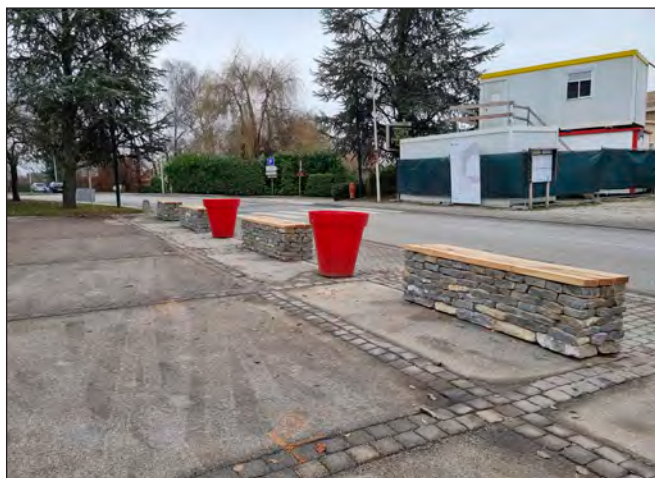
Embellissement et sécurisation du parking centre bourg
