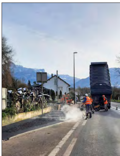
Enrobé des trottoirs de la Perrine
