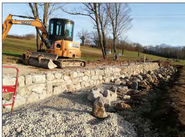
Réparation du mur de soutènement accès réservoir de Trolaz
