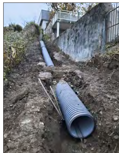
Travaux de drainage
