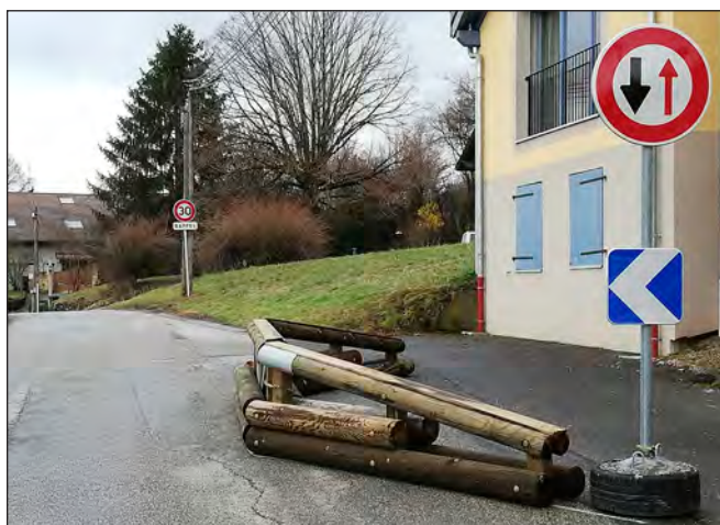
Mise en place de chicanes de ralentissement
