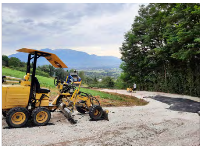
Réfection de la route de la Colonie
