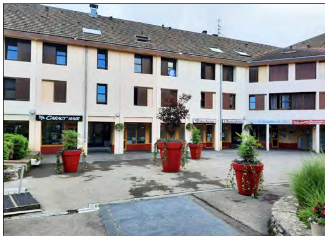
Embellissement de la placette des commerces
